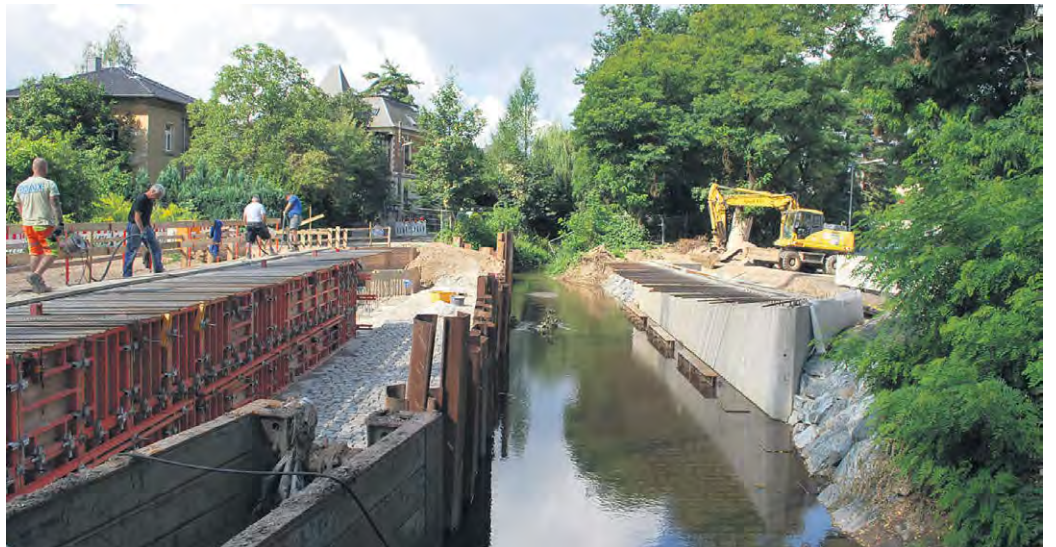
AN DIESER STELLE entsteht die neue Brücke über den Lockwitzbach. Sie muss höher als die bisherige werden, damit sich im Hochwasserfall nicht das Wasser staut. Foto: Trache
