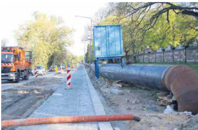
BIS ENDE JUNI sollen die Bauarbeiten dauern.
