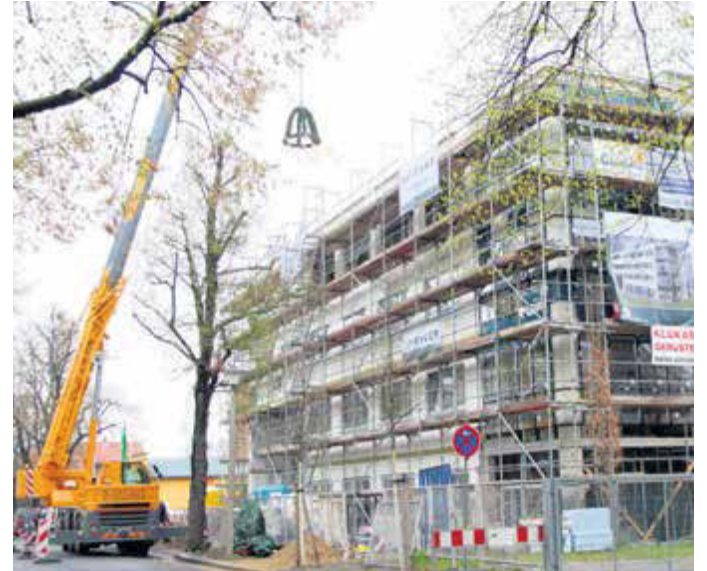
AM 4. APRIL SCHWEBTE die Richtkrone über dem neuen Produktionsgebäude. Foto: Pohl
