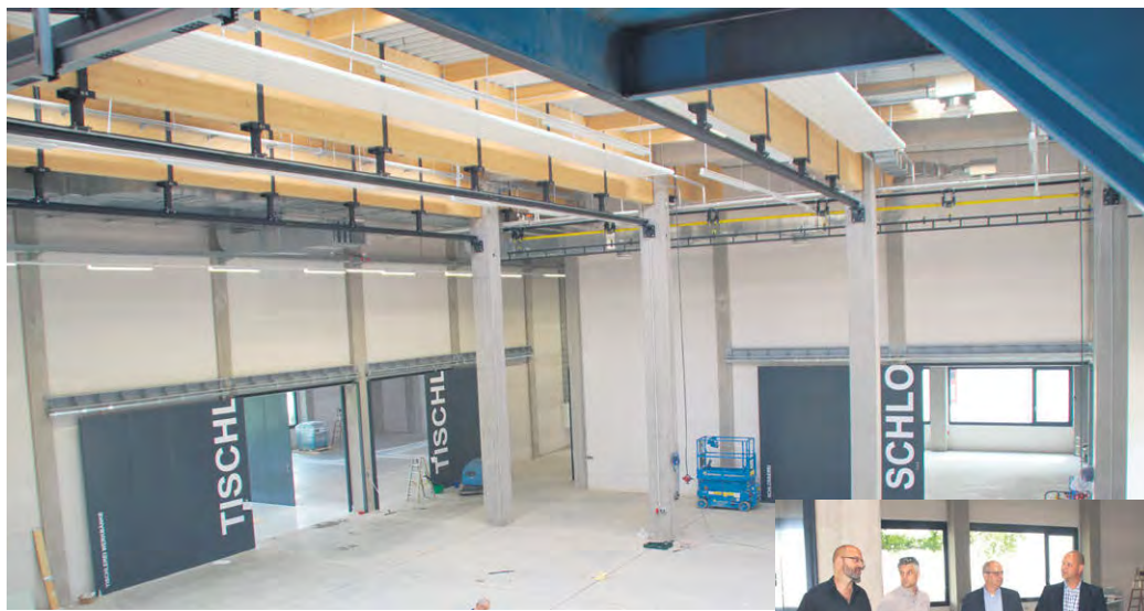
BLICK IN DIE neue Montagehalle. Kleines Bild: Bei der Baustellenbesichtigung: (v. l. n. r.) Lutz Hofmann, Technischer Direktor des tjg. theater junge generation, Mario Radicke, Technischer Direktor der Staatsoperette Dresden, Axel Walther, Geschäftsführer KID Kommunale Immobilien Dresden, und Projektleiter der KID Florian H. Brandenburg.
