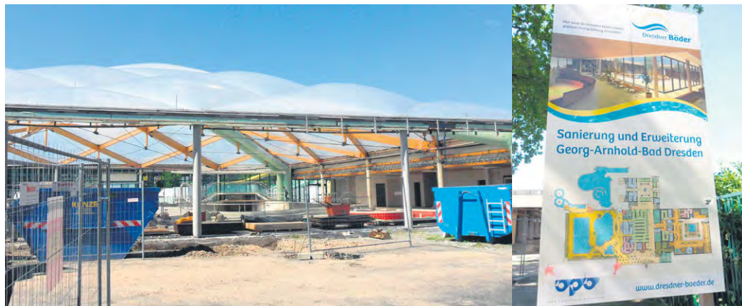
BAUARBEITEN UND BAUTAFEL an der Schwimmhalle des Arnholdbades.
