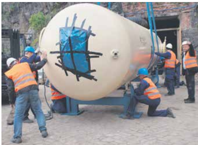
DER BESCHLEUNIGERTANK AUF seinem Weg in den Schacht des Felsenkellers. Foto: Steffen Dietrich
