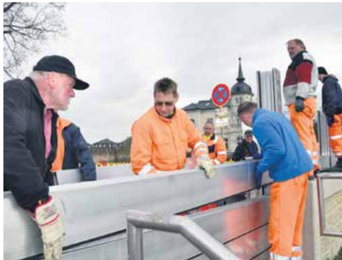
**STÜCK FÜR STÜCK** montieren die Mitarbeiter des Regiebetriebes die Elemente der mobilen Hochwasserschutzwand. Foto: Möller
