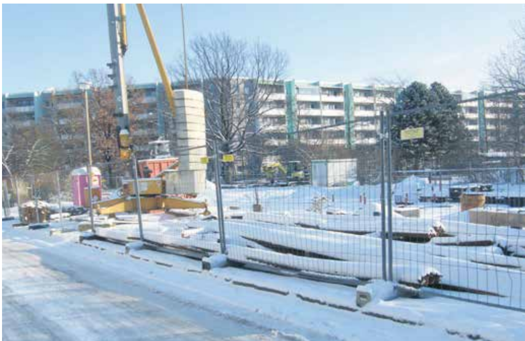
HINTERM BAUZAUN TUT sich etwas: Auf dem Grundstück Elsterwerdaer Straße 21 haben die Arbeiten für das neue Kinder- und Jugendhaus PIXEL begonnen. Der große Kran ist montiert und bald soll die Bodenplatte fertig gestellt werden. Der Neubau ist ein Projekt der Städtebauförderung von Bund, Ländern und Gemeinden. Foto: Ziegner
