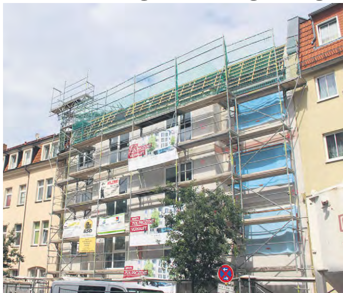
BEI PRÄCHTIGEM WETTER wurde in der Leisniger Straße ein zünftiges Richtfest mit allem, was dazu gehört, gefeiert. Foto: PR
