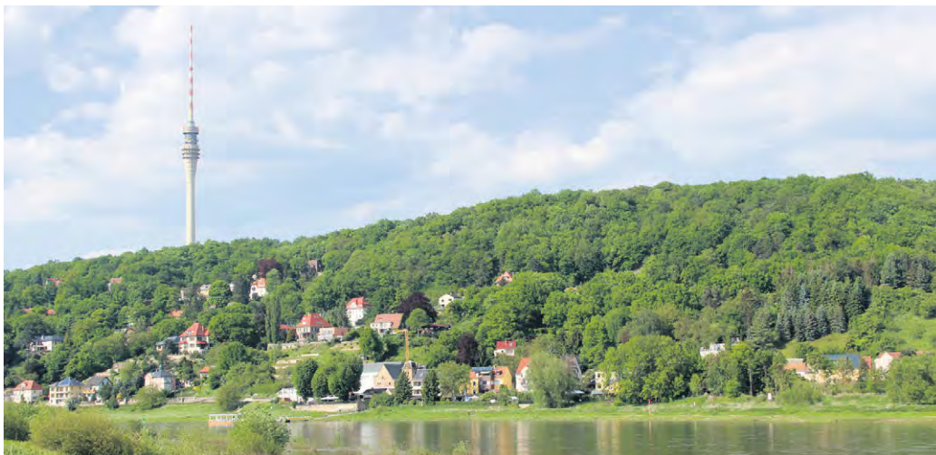
DER FERNSEHTURM IST mit seiner Höhe von 252 Metern ein unübersehbares Wahrzeichen für ganz Dresden. Der 1969 in Betrieb genommene Turm wurde am 30. Juni 1991 für die Öffentlichkeit geschlossen. Derzeit dient der Turm technischen Zwecken, verbreitet werden u. a. Rundfunk- und Fernsehprogramme. Foto: Pohl
