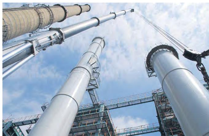
**IM JULI WURDE** die neue Schornsteinanlage des Innovationskraftwerkes Reick montiert. Sie soll den bisherigen 200 Meter hohen Schornstein (links im Bild) ersetzen, der ab September zurückgebaut wird. Foto: Trache
