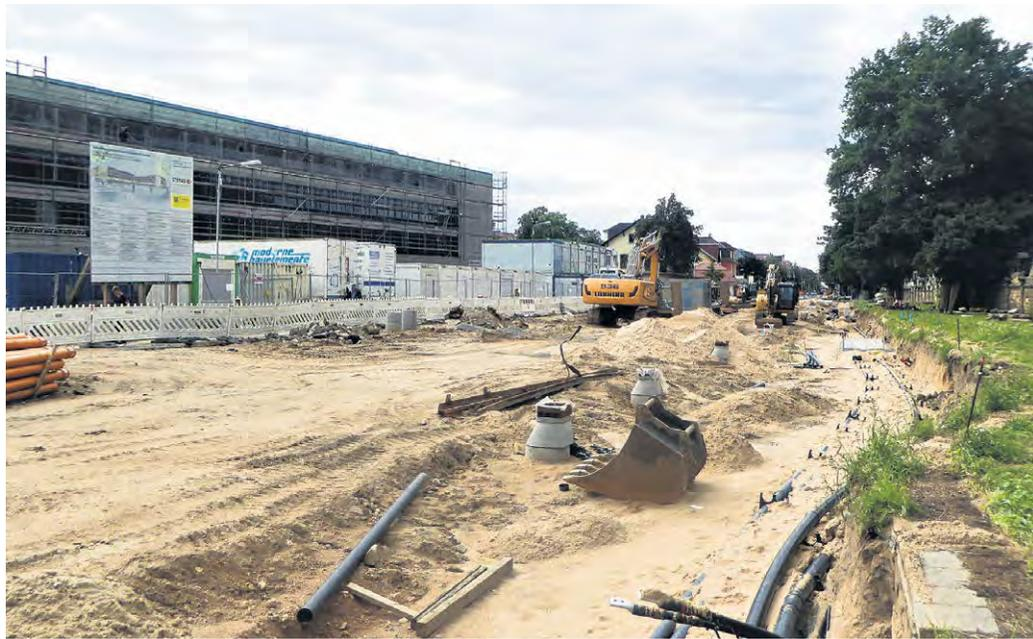
**VOR DEM DOPPELSCHULSTANDORT** in Tolkewitz wird die Wehlener Straße instand gesetzt. Sie ist voraussichtlich bis Dezember gesperrt. Fast alle Versorgungsleitungen werden erneuert oder saniert. Neu verlegt werden eine Trinkwasserleitung und ein Mischwasserkanal. Ab 22. Dezember sollen hier die Straßenbahnen der Linie 4 und 6 wieder rollen. Die neue Gleisschleife wird spätestens im Sommer 18 fertig. Foto: Simmert
