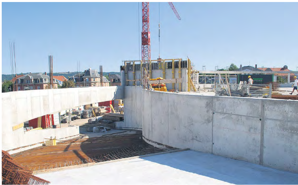
VERSCHIEDENE GEWERKE GEBEN sich auf der Baustelle des neuen Einkaufs- und Dienstleistungszentrums in Zschachwitz die Klinke in die Hand. Ende September soll bereits der Rohbau fertig sein. Im Bild: die Auffahr-rampe zum Parkdeck. Foto: Trache
