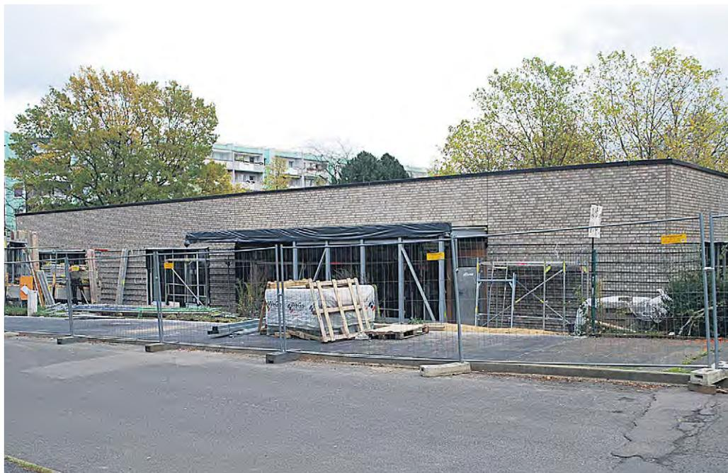
**WEIHNACHTSFEIER IM NEUEN PIXEL?** So sieht es derzeit nicht aus. Der Rohbau mit Dach und Fassade ist fertig, im Inneren arbeiten derzeit die Ausbaugewerke. Ende Oktober, Anfang November sind die Firmen für Heizung, Lüftung, Sanitärtechnik und Elektrotechnik tätig. Auch Trockenbau- und Estricharbeiten werden ausgeführt. Nach Auskunft des Hochbauamtes soll das Haus 2018 bezugsfertig werden. Foto: Trache
