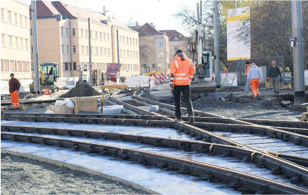
**DIE GLEISBAUARBEITEN** auf der Lockwitzer, Hugo-Bürkner- und Reicker Straße sind in vollem Gange. Unter anderem wird das Gleisdreieck erneuert und die Haltestellen in dem Bereich barrierefrei gestaltet. Auf der Reicker Straße werden auch die Fahrbahnoberleitungen erneuert. Damit verbunden sind Straßensperrungen, Umleitungen und Schienenersatzverkehr für die Linie 9 und 13 in Richtung Prohlis. Foto: Ziegner
