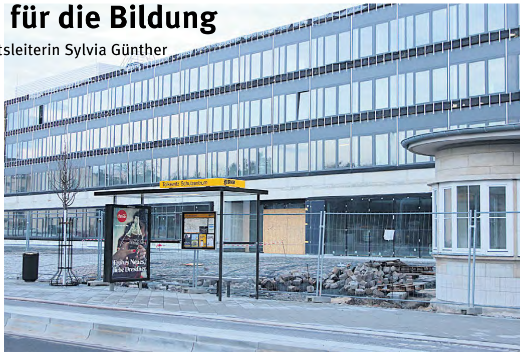
AUCH WENN ES auf dem Doppelschulstandort in Tolkewitz noch nach Baustelle aussieht – nach den Februarferien sollen hier das neue Gymnasium und die 32. Oberschule eröffnet werden. Foto: Pohl
