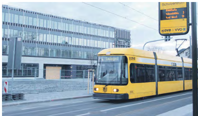
NÄCHSTER HALT: SCHULZENTRUM. An der Wehlener Straße sind vor dem Tolkewitzer Schulcampus neben dem neuen Gleisbett auch zwei barrierefreie neue Haltestellen entstanden. Foto: Pohl
