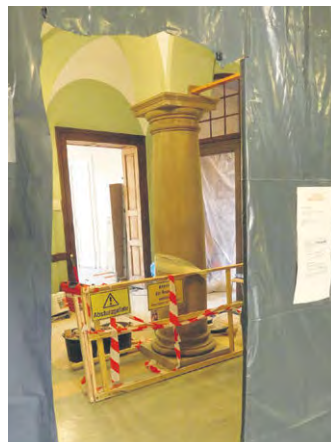
BAUSTELLE ORTSAMT LEUBEN.
