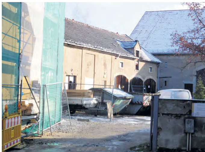
DIE SANIERUNG HAT begonnen.
