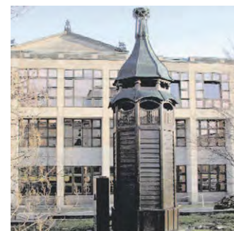
DAS EINSTIEGSGEBÄUDE SEMPEROPER zum Altstädter Abfangkanal.
