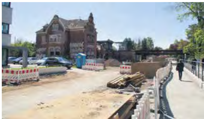
WANN WERDEN HIER die Bauarbeiten regulär weitergehen? Foto: Dietrich
