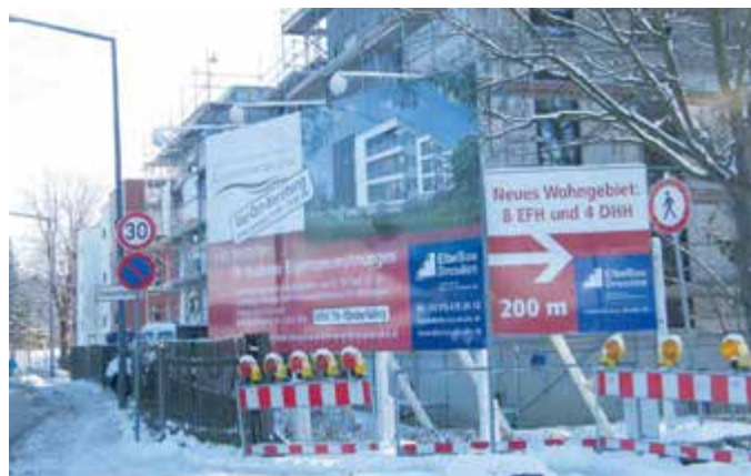
BAUEN BOOMT – WIE hier am Kleinschachwitzer Ufer entstehen an etlichen Standorten in Laubegast und Leuben neue Wohnungen.
