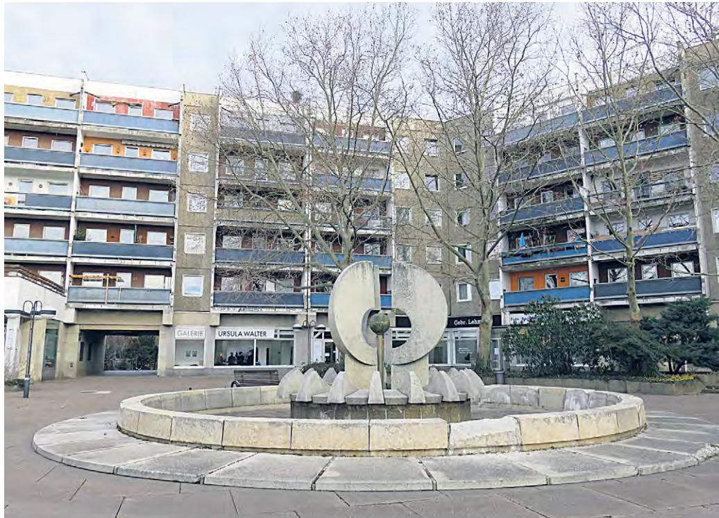
BRÖCKLIGER CHARME. Die Häuserzeile an der Ostseite des Neustädter Marktes hat schon bessere Zeiten gesehen. Jetzt soll saniert werden. Foto: Pohl
