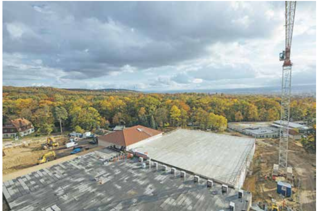
DER NEUE TRINKWASSERBEHÄLTER an der Fischhausstraße trägt dazu bei, den steigenden Trinkwasserbedarf der Landeshauptstadt zu sichern.
