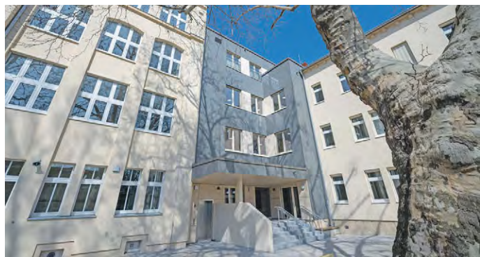
DIE SANIERUNG DER 15. Grundschule an der Görlitzer Straße ist beendet.
