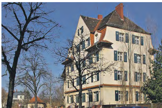
IN DEN RUND ZEHN JAHREN seines Wirkens in Dresden wurde Hans Erlwein zu einem Wegbereiter der Neuen Sachlichkeit. Zu den nach seinen Plänen errichteten Gebäuden zählt das Wohnhaus Am Wilden Mann 6/8. (Lesen Sie mehr dazu auf Seite 8.) Foto: Brendler
