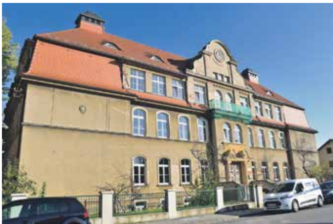
DAS DENKMALGESCHÜTZTE GEBÄUDE erhält eine Frischekur. Foto: Trache
