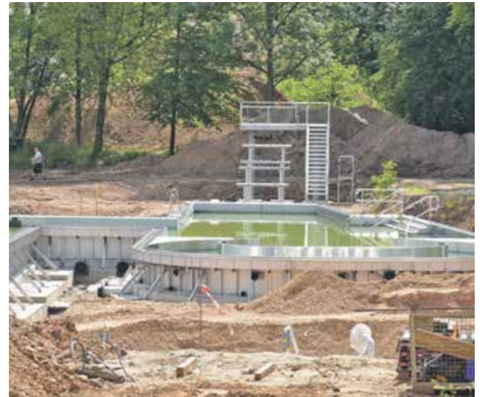
IM JUNI 2020 wurde auf der Baustelle des Kombibades in Prohlis Richtfest gefeiert. Im zweiten Halbjahr 2021 soll das Hallenbad eröffnet werden und 2022 folgt das neue Freibad. Foto: Archiv/Trache
