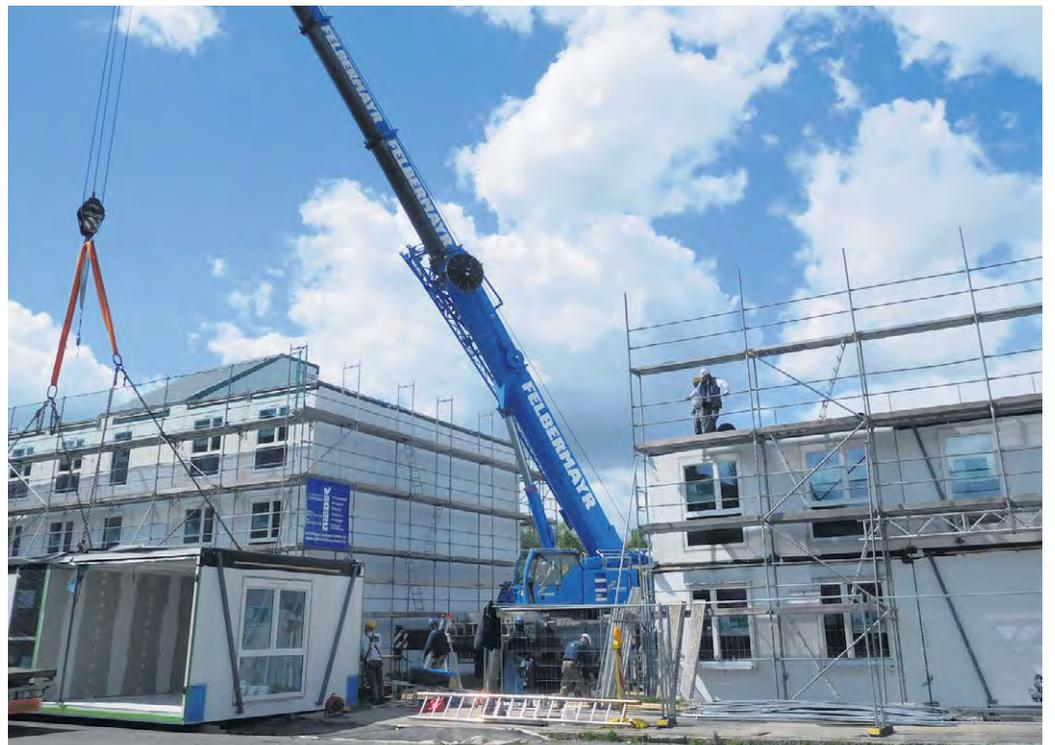
**BAUBEGINN AN DER** Reicker Straße: Die ersten Geschosse von zwei Wohnhäusern sind schon fertig. Die VONOVIA baut auf einer Fläche von 6.600 Quadratmeter in mehreren Gebäuden 83 Wohnungen. Die vorgefertigten Wohnmodule werden per Kran aufgesetzt und sorgen für einen schnellen Baufortschritt. Im Umfeld des Projektes werden zwei Spielplätze und Stellplätze für Pkw errichtet.
