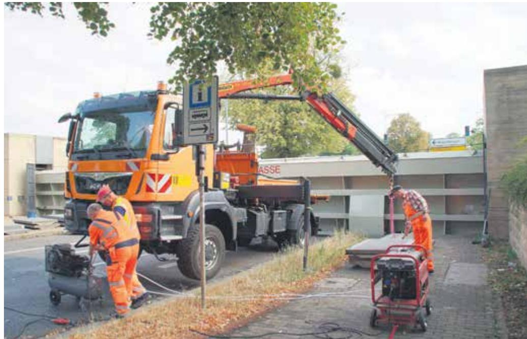
MIT EINEM KRAN wurden die für den Aufbau des insgesamt 20 Tonnen schweren Hochwasserschutztors notwendigen Einzelteile an die passenden Stellen gehoben. Fotos (2): Steffen Dietrich
