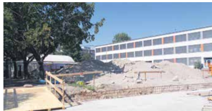
DIE SANIERUNG DER 30. Oberschule am Unteren Kreuzweg ist weitgehend abgeschlossen. Foto: Naumann
