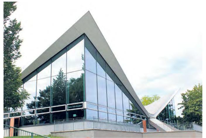
**MIT SEINEM GEFALTETEN DACH** ist das Wassersportzentrum ein architektonisches Kleinod am Blasewitzer Elbufer. Schräge Betonstützen fangen die Lasten der selbsttragenden Stahlbetondecke ab. Foto: Pohl
