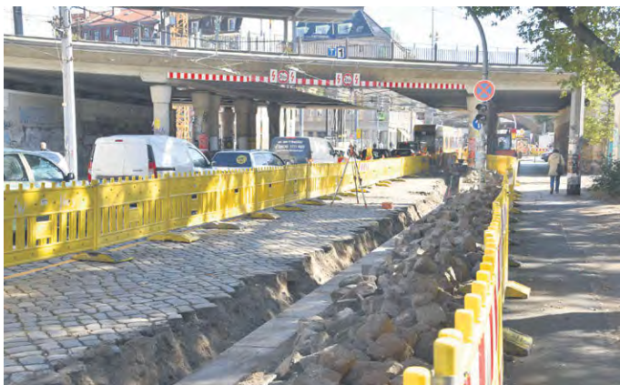
DAS KOPFSTEINPFLASTER ZWISCHEN Johann-Meyer-Straße und Dammweg wird durch Asphalt ersetzt. Damit verbessert sich die Verkehrssicherheit für den Radverkehr.
