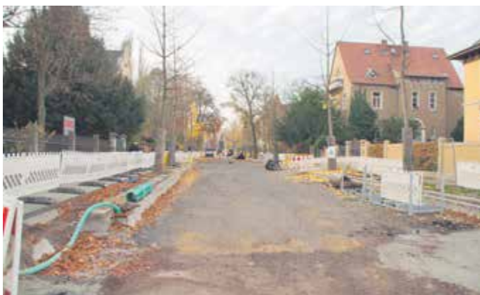
BAUSTELLE OSKARSTRASSE, BLICK in Richtung Wasaplatz. Foto: Dietrich
