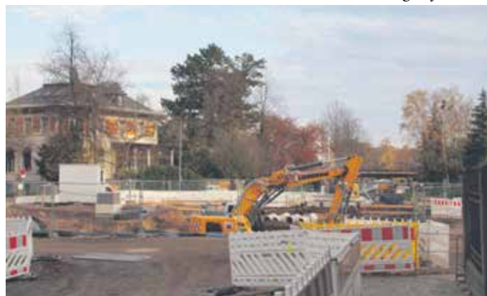
BAUARBEITEN AM GUSTAV-ADOLF-PLATZ.
