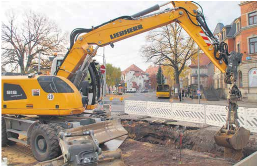
AUSHUBARBEITEN AM WASAPLATZ.
