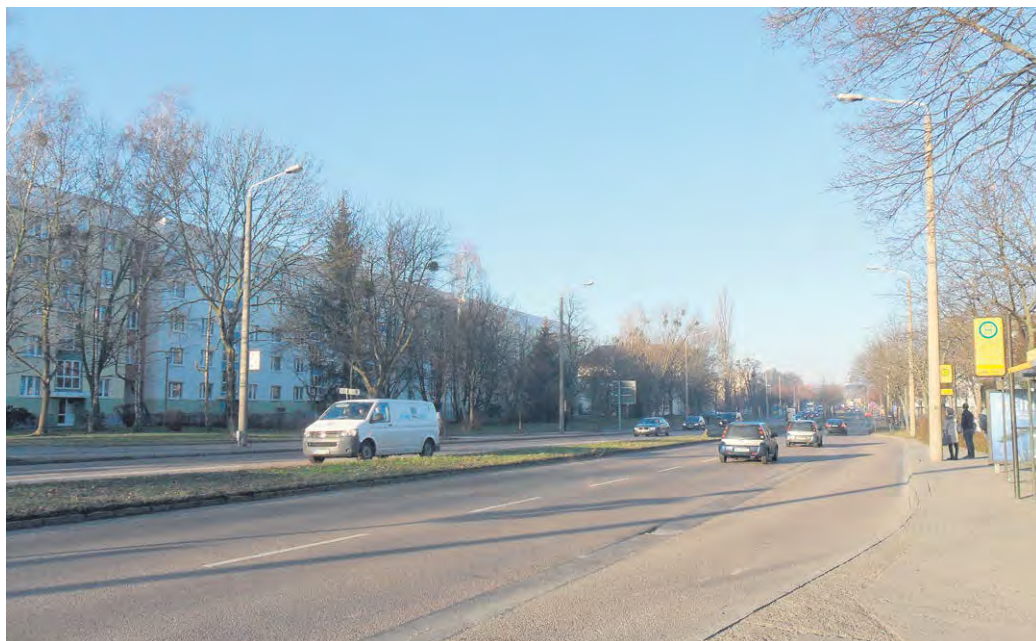
DER ZELLESCHER WEG wird im Rahmen des Projekts „Stadtbahn 2020“ in den nächsten Jahren umgebaut. Derzeit wird erneut im Stadtrat darum gerungen, ob es eine vierspurige Variante, wie jetzt vorhanden, geben wird oder ob es bei der 2016 beschlossenen neuen zweispurigen Variante bleibt. Foto: Steffen Dietrich
