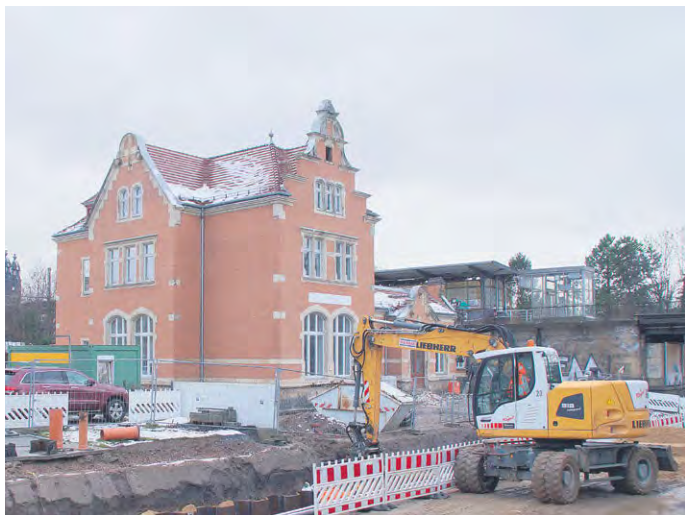
BAUARBEITEN AM HALTEPUNKT STREHLEN.
