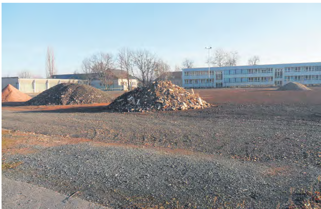
DER SPORTPLATZ DES Universitätssportzentrums der Technischen Universität Dresden an der Teplitzer Straße ist derzeit noch eine Bafläche. Noch in diesem Jahr soll der Sportplatz wieder neu gebaut und für den Sport bereit gestellt werden.
