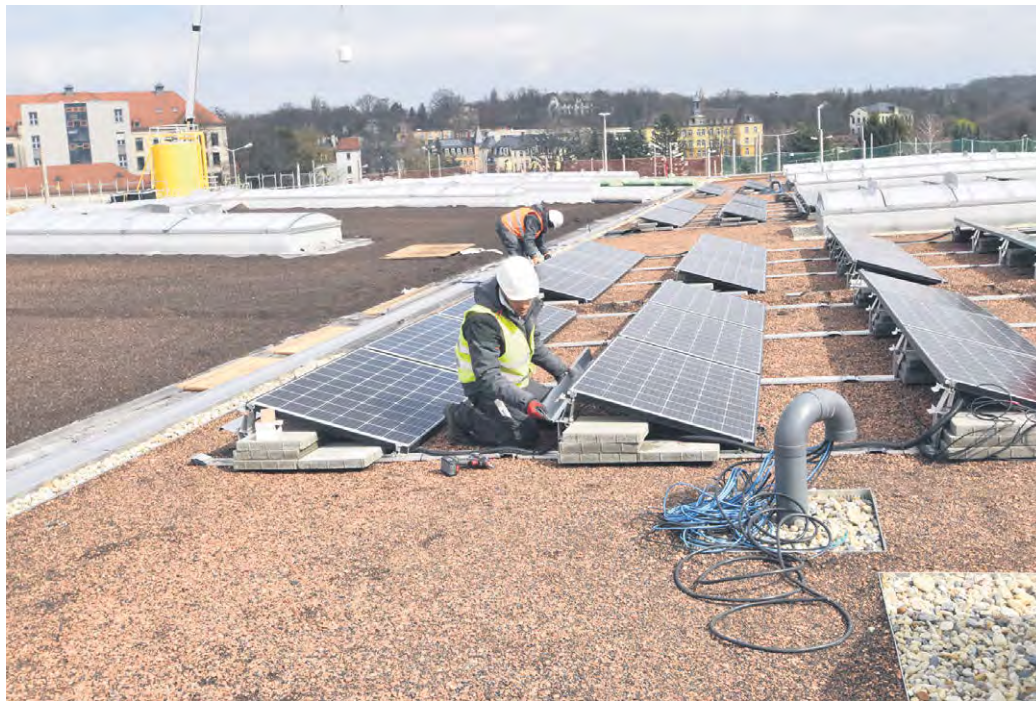
IM STRASSENBAHNHOF TRACHENBERGE sind Ende März zwei neue Carports für die Straßenbahnen fertiggestellt worden. Die Inbetriebnahme erfolgte am 1. April. Aktuell läuft der Aufbau einer rund 5.500 Quadratmeter großen Solarfläche auf den beiden Dächern. (Weiter auf S. 6) Foto: Möller
