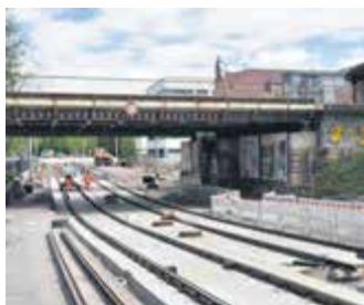
DIE OSKARSTRASSE MIT Blick in Richtung Wiener Straße. Unter dieser Unterführung soll der Autoverkehr künftig nicht mehr rollen.
