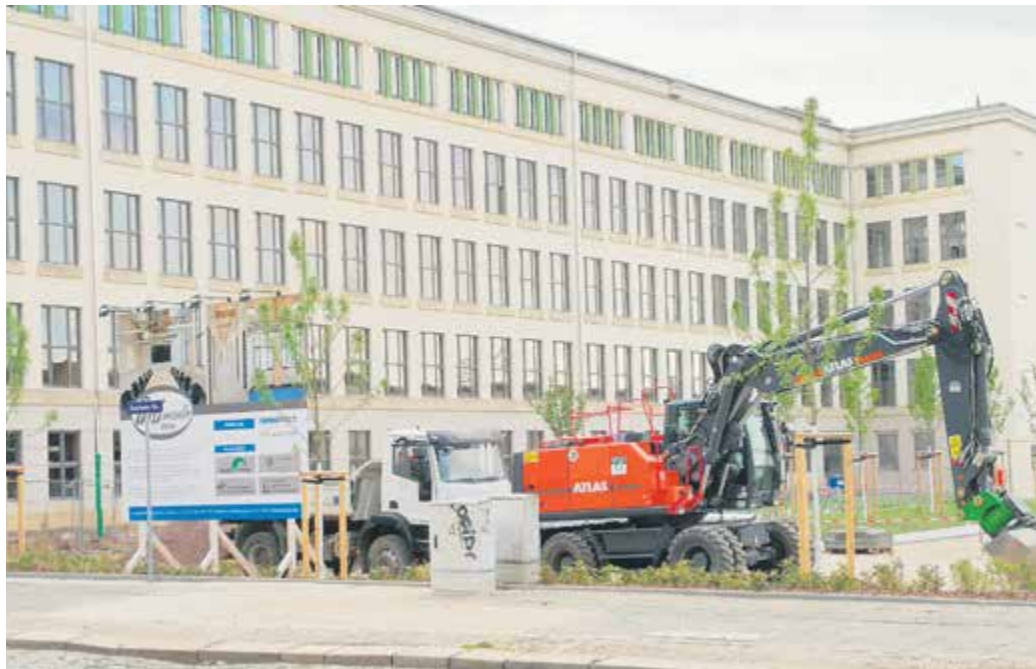
LETZTE BAUARBEITEN VOR der umgebauten Fabrikhalle. Mit den „Universellen Werken“ an der Zwickauer Straße ist ein neues Innovationszentrum für Leichtbau entstanden. Foto: Paul Dietrich
