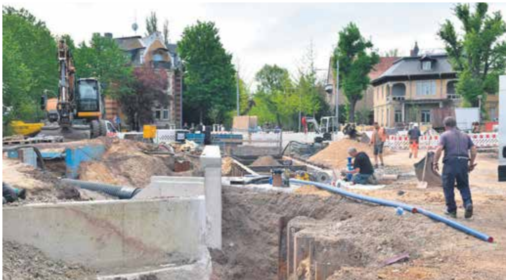
AUF DER BAUSTELLE WASAPLatz.
