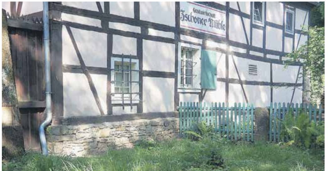
DIE ZSCHONER MÜHLE ist auch ein sehenswertes Denkmal der Baugeschichte.
