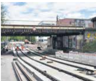
DIE OSKARSTRASSE MIT Blick in Richtung Wiener Straße. Unter dieser Unterführung soll der Autoverkehr künftig nicht mehr rollen.
