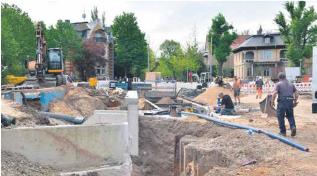
AUF DER BAUSTELLE WASAPLatz.
