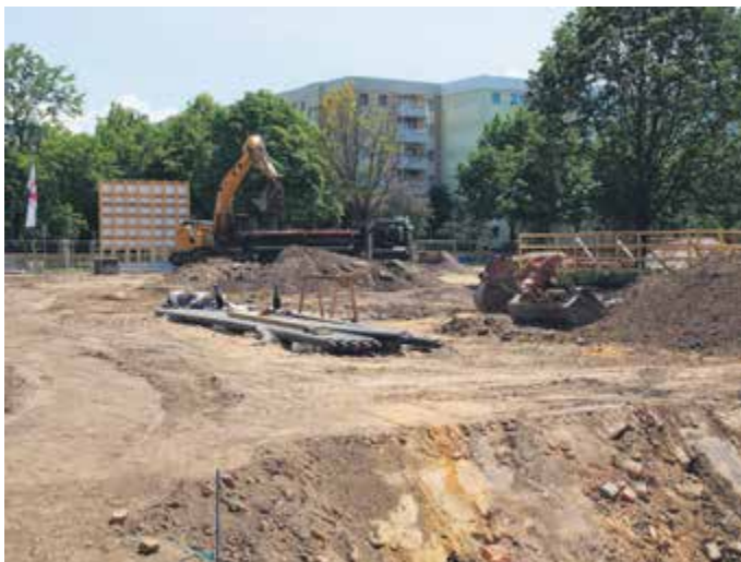
AUF DEM FRÜHEREN Parkplatzgelände hinter der Hochschule für Technik und Wissenschaft (HTW Dresden) haben die Bauarbeiten zur Errichtung eines neuen Lehr- und Laborgebäudes begonnen. Foto: Steffen Dietrich
