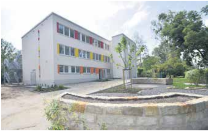
FRISCHZELLENKUR FÜR DIE Kita im Binzer Weg. Neu ist u.a. das dem Gebäude vorgelagerte Treppenhaus. Foto: Möller
