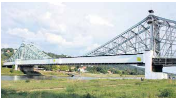
DIE SANIERUNG DES Fußweges auf dem Blauen Wunder erfolgt unter schützenden weißen Planen. Foto: Pohl
