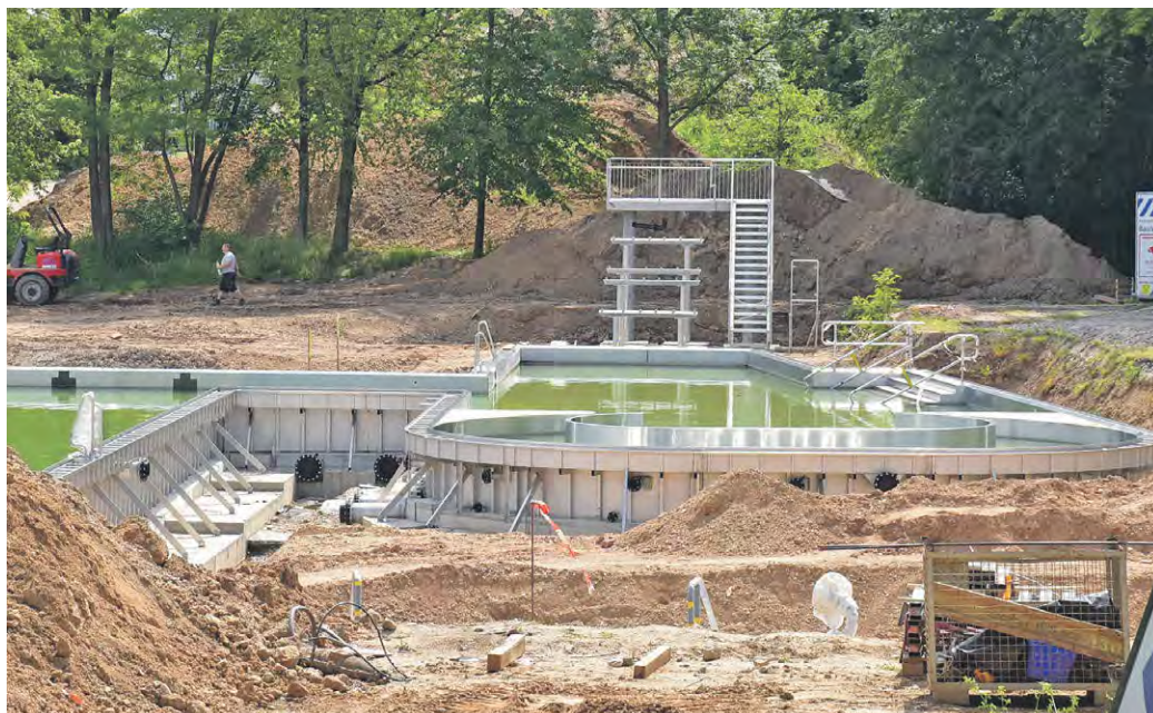
SCHON WASSER IM BECKEN? Bis hier im Prohliser Bad geplätscht werden kann und die Außenanlagen zum Sonnenbad einladen, vergeht noch eine geraume Weile. Aber die Arbeiten liegen im Plan. Fotos: Trache
