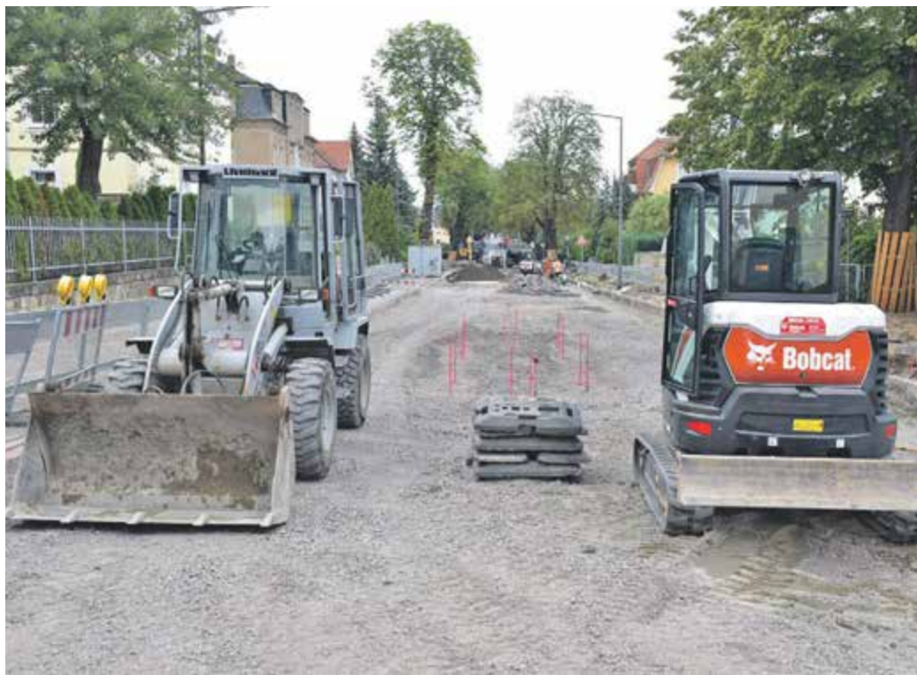
EIN TEIL DER Lugaer Straße wird derzeit unter Vollsperrung saniert. Damit Passanten und vor allem Schüler die Straße sicherer queren können, entsteht eine Mittelinsel. Der Standort ist hier im Bild durch rote Stäbe in der Mitte der Straße markiert. Fotos: Trache
