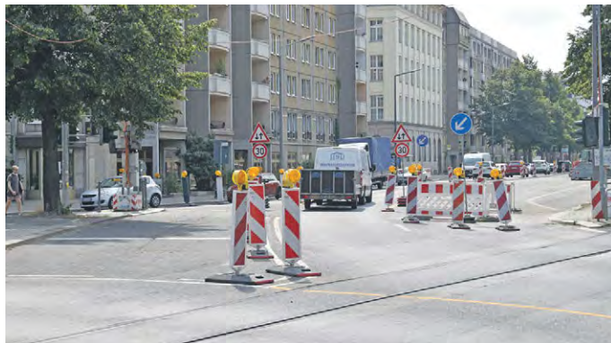
DIE ALBERTSTRASSE WIRD derzeit auf drei Fahrspuren zurückgebaut.
