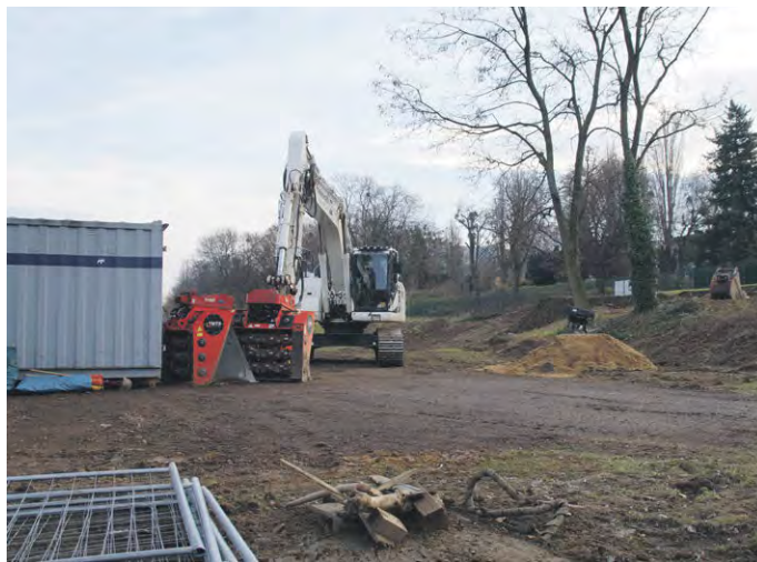
BAUSTELLE AN DER Stadtgutstraße.
