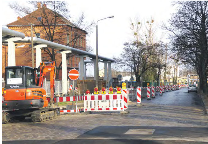
BAUARBEITEN AN DER Zwickauer Straße.
