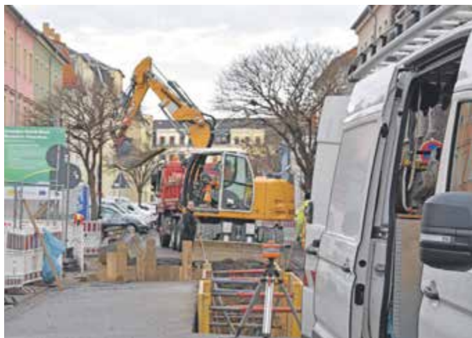
DIE BAUARBEITEN SIND in der Oschatzer Straße in ihre letzte Phase getreten. Foto: Möller
