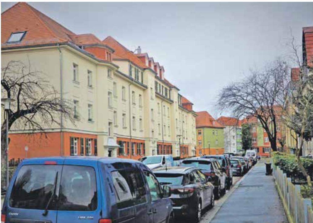
DIE HÄUSERZEILE NAUNDORFER Straße Nr. 8, 10, 12, 14 und 16 wurde von der Baufirma Emil Lommatzsch (Trachau) errichtet. Foto: Brendler
