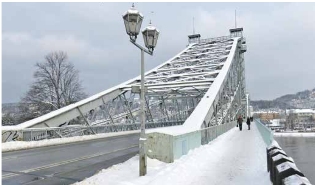
DIE ERNEUERUNGSARBEITEN AN der Loschwitzer Brücke verschieben sich weiter.
