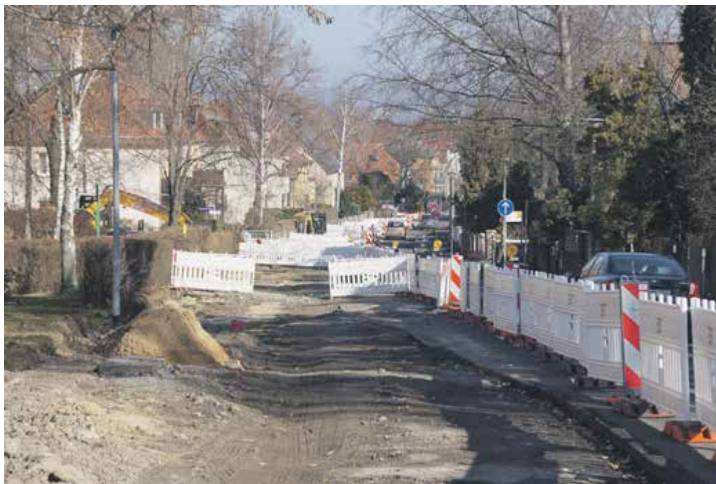
BLICK IN DIE wegen Bauarbeiten halbseitig gesperrte Caspar-David-Friedrich-Straße mit Blick Richtung Schurichtstraße. Fotos (2): Steffen Dietrich
