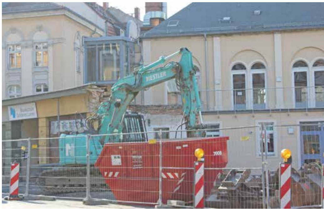
MIT SCHWEREM GERÄT rücken die Bauleute den Gebäuderesten entlang der Straße Alttrachau zu Leibe. Die feierliche Grundsteinlegung ist für die Zeit nach Ostern geplant. Foto: Möller
