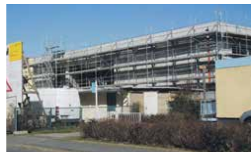
DER ROHBAU DER neuen Sporthalle. Foto: Ziegner
