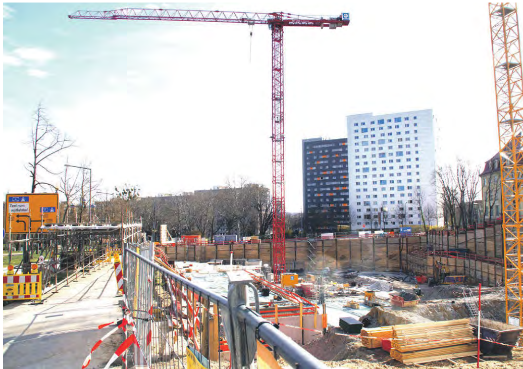
AM FRITZ-LÖFFLER-PLATZ DREHEN sich gleich zwei Baukräne auf einer Großbaustelle.
