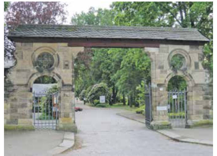
DAS HISTORISCHE EINGANGSPORTAL soll saniert werden.
