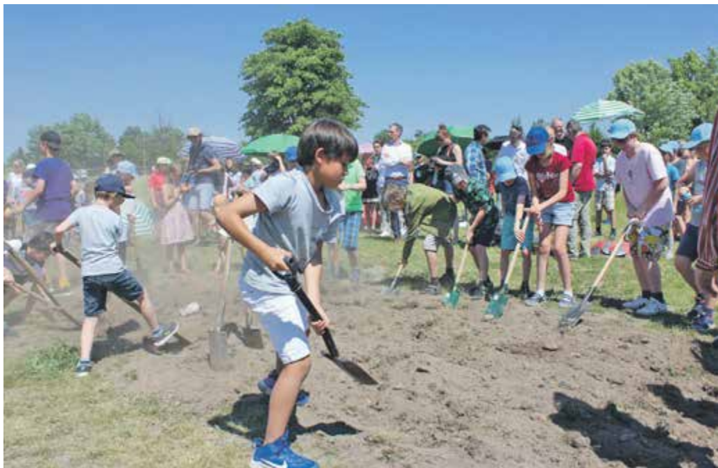
SYMBOLISCHER 1. SPATENSTICH für den Schulneubau. Nach den Gästen beteiligten sich auch die Schüler und lockerten den Boden für die künftige Schulbaustelle. Foto: Pohl
