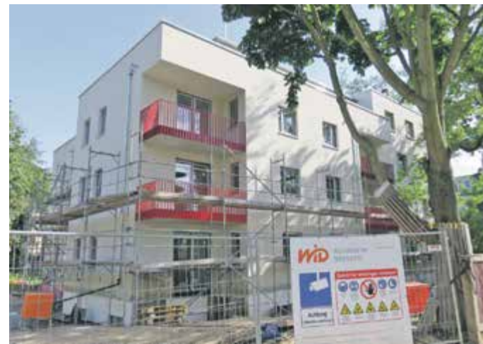
AN DER JÜNGSTSTRASSE baut das städtische Wohnungsunternehmen ein Mehrfamilienhaus. Foto: Pohl
