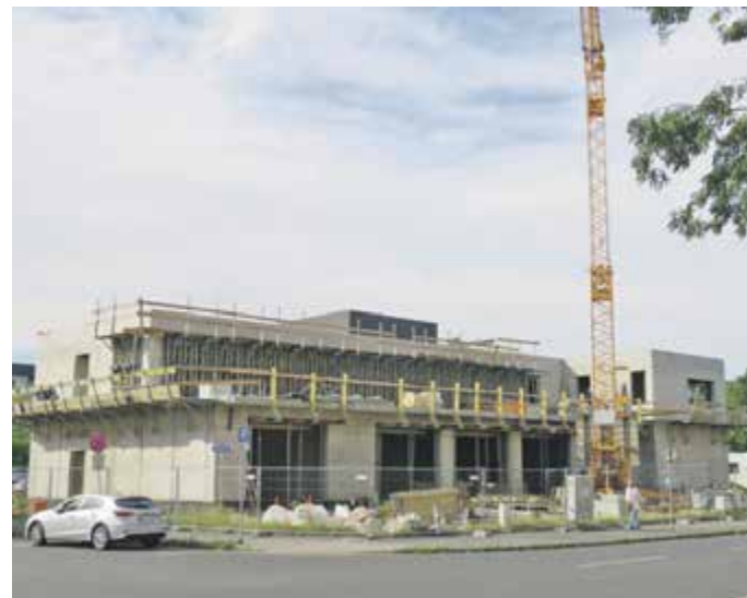
DER ROHBAU DER künftigen Rettungswache in Leuben steht: Die Fassade des Gebäudes soll nach Fertigstellung begrünt werden, geplant sind ein Gründach sowie eine Photovoltaikanlage. Foto: Pohl
