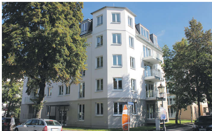
35 NEUE WOHNUNGEN entstanden an der Alemannenstraße. Foto: Pohl
